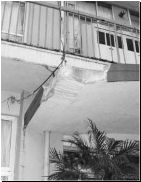
区立10中昇降口ひさし（12月17日・視察時に撮影）
