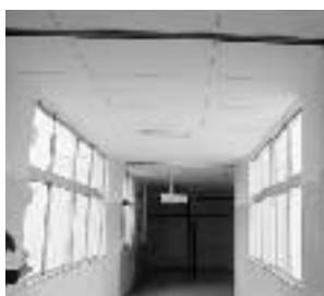
改善された学校の廊下
