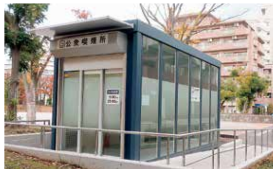
しょうぶ沼公園内に設置した公共喫煙所
